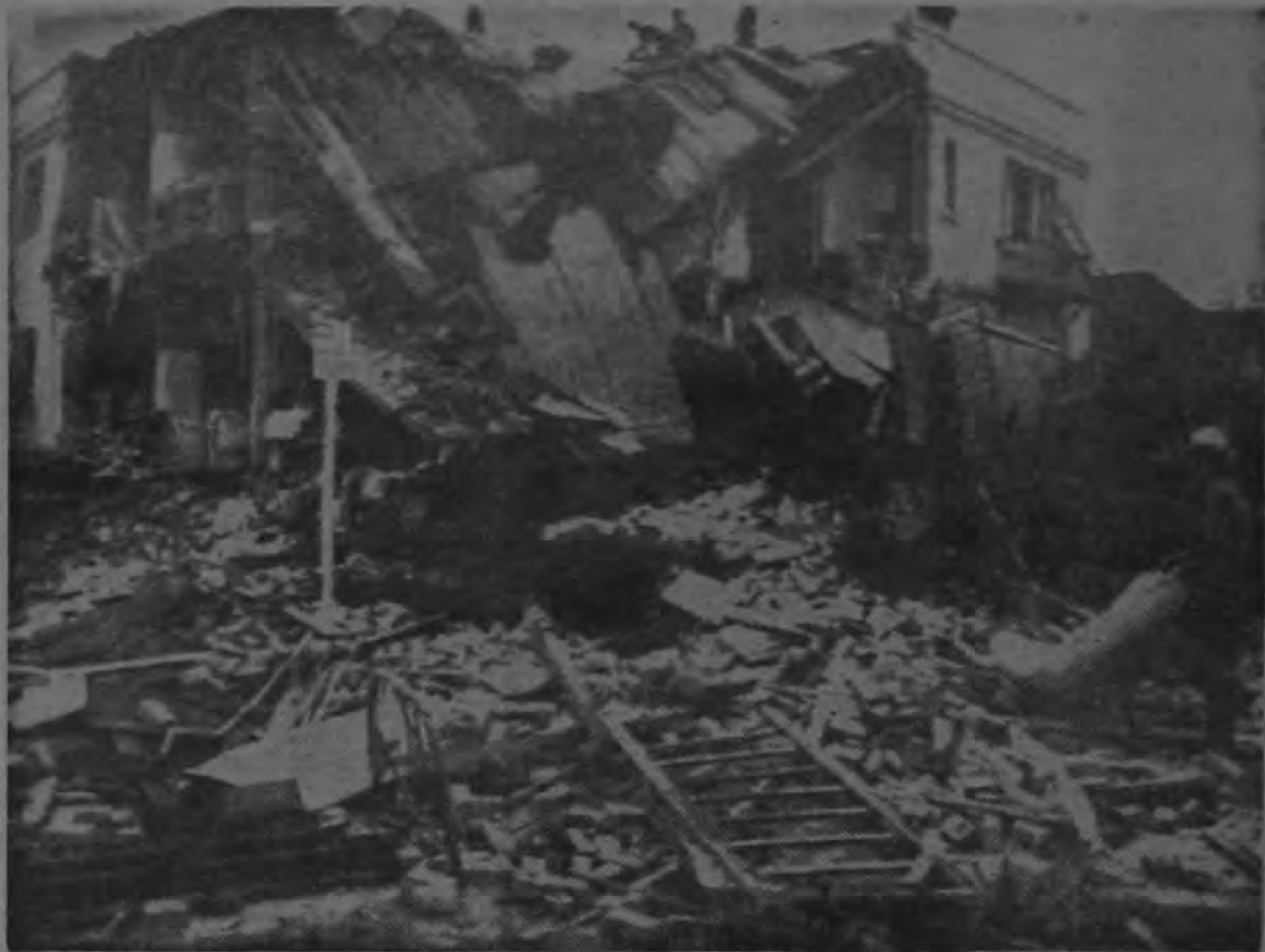
Los bomberos examinan los escombros de una casa de apartamentos en Los Angeles después que una explosión hizo volar cuatro unidades del edificio, cerca del centro comercial. Por lo
